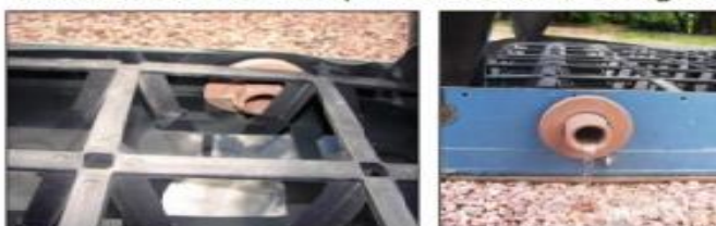
Detalhe: Altura de 5cm para escoamento da água
