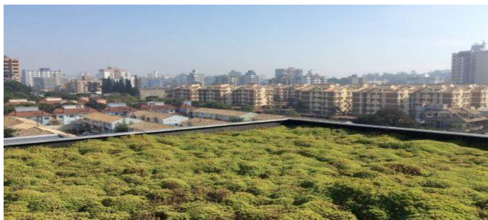
FIGURA 26: Telhado verde com sistema alveolar leve
