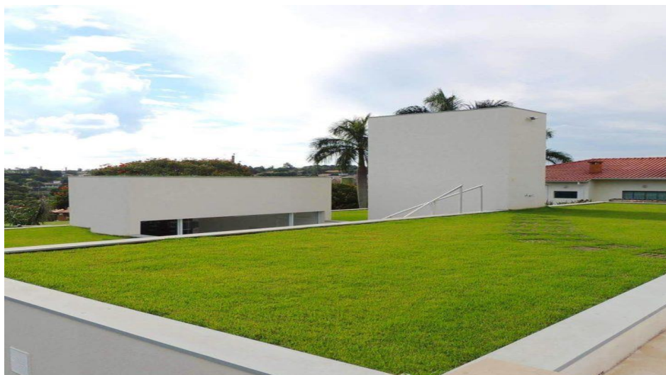
FIGURA 38: Telhado verde com sistema laminar alto
