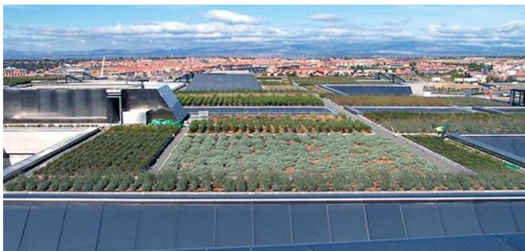
FIGURA 16: Telhado verde com plantas aromáticas, Banco Santander- Madrid
