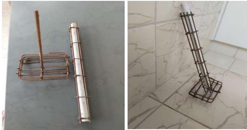
Figura 5. Armação de ferragens para posterior enchimento com concreto, utilizando estribos, arames, vergalhão e cano de PVC para garantir menor peso.
