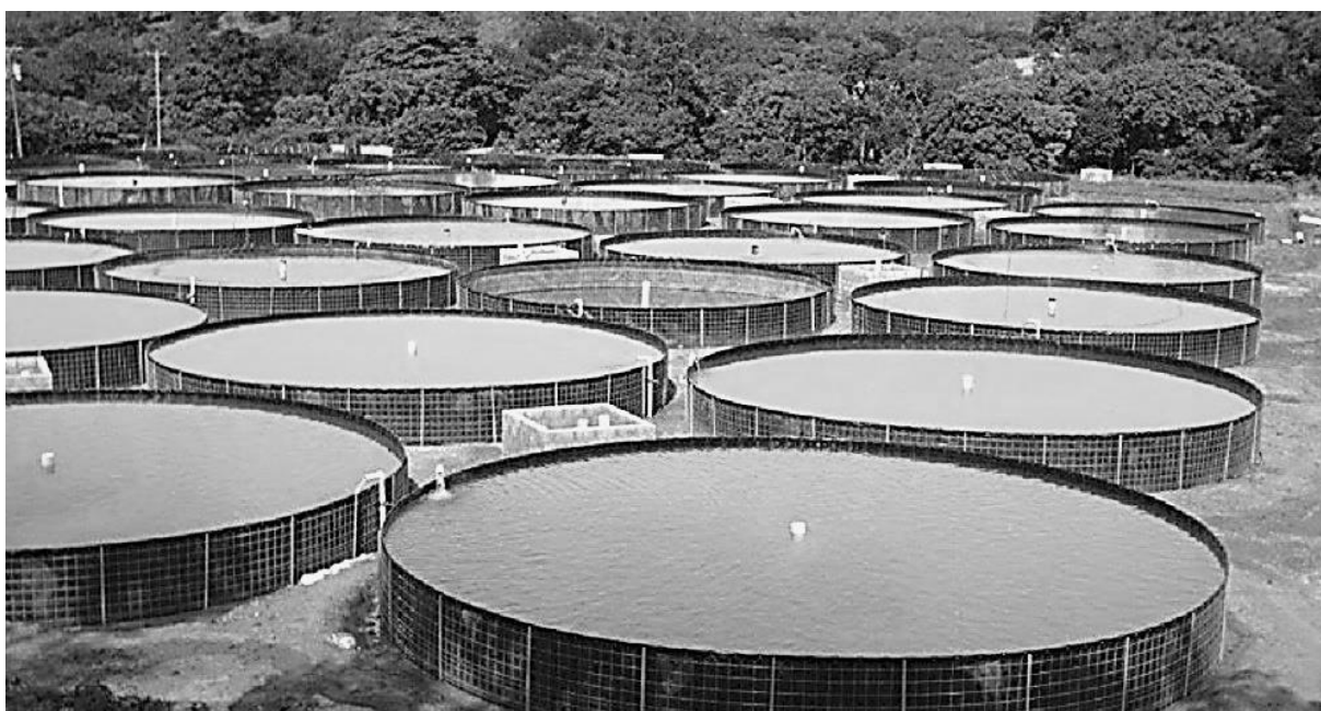
Figura 23 – Tanques revestidos circulares elevados
