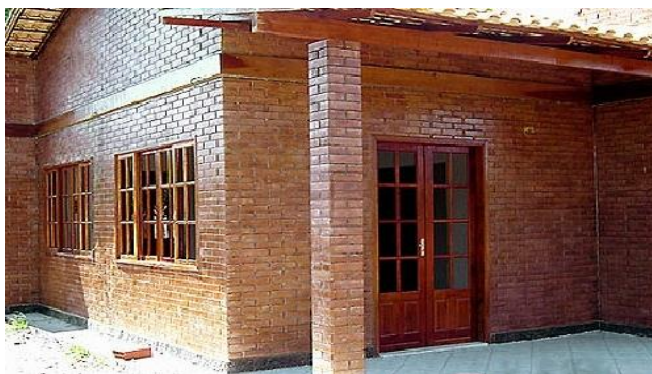
Figura 2-Casa reciclada: tijolos feitos a partir de resíduos de construção e demolição
