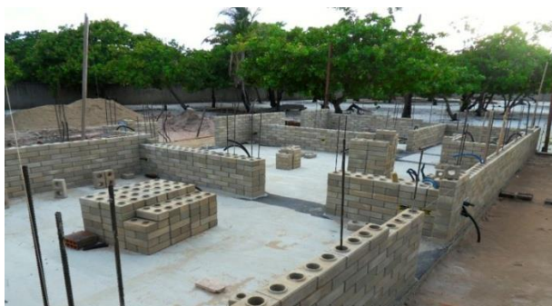
Figura 3 -Tijolo feito de sobras da construção civil
